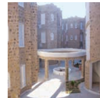
المعهد العالي للدراسات التكنولوجية بتوزر 13 بناء بالطوب الصّلب من توزر يجمع بين جدران حاملة، وتغليف يمتاز بقوة الصّمود، والارتفاعات المظلة، ورونق الواجهات، وانسجام الألوان.
