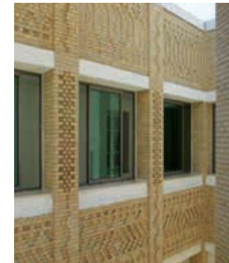
المعهد العالي للدراسات التكنولوجية بتوزر 13 بناء بالطوب الصّلب من توزر يجمع بين جدران حاملة، وتغليف يمتاز بقوة الصّمود، والارتفاعات المظلة، ورونق الواجهات، وانسجام الألوان.
