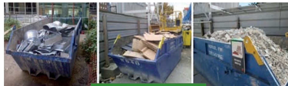
مثال لفرز النفايات «مشروع بناء في فرنسا حسب نهج الجودة البيئية العالية».
