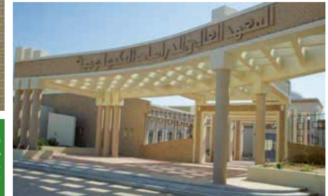
المعهد العالي للدراسات التكنولوجية بتوزر 13 بناء بالطوب الصّلب من توزر يجمع بين جدران حاملة، وتغليف يمتاز بقوة الصّمود، والارتفاعات المظلة، ورونق الواجهات، وانسجام الألوان.
