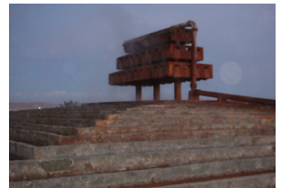
Système de refroidissement des eaux thermales à Jbil
