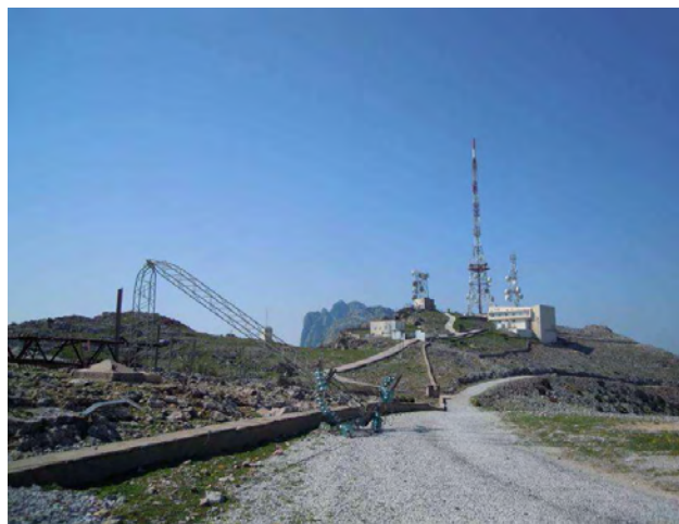
Antennes et station de transmission au sommet
