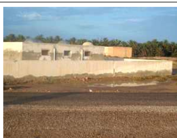
Vue de l'extérieur du Hammam thermal de Zarat (2013)
