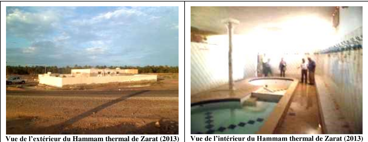
Vue de l'extérieur du Hammam thermal de Zarat (2013)
