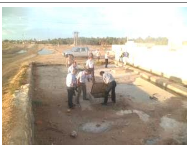
Conduite d'alimentation du Hammam thermal (2013)
