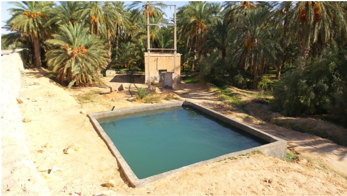
L'aménagement de bassins d'eau, une des réponses à l'allongement du tour d'eau (Sedada, Degache).
