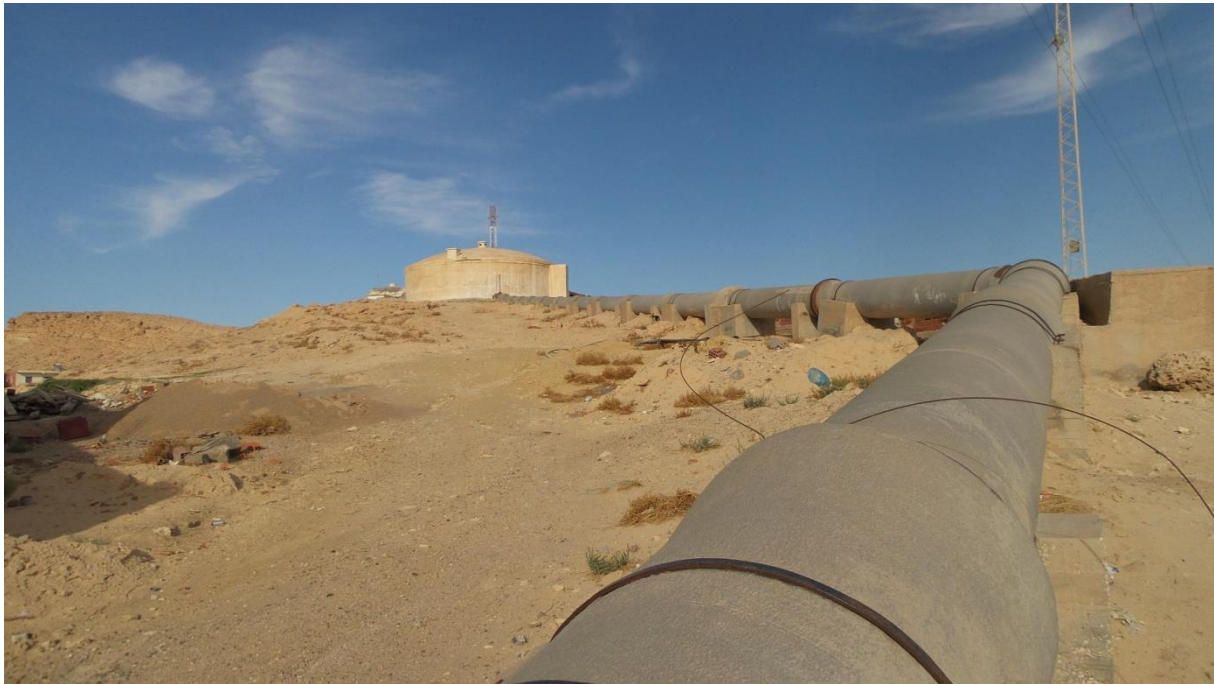
La mobilisation de la nappe profonde dans la Presqu'île de Kébili
